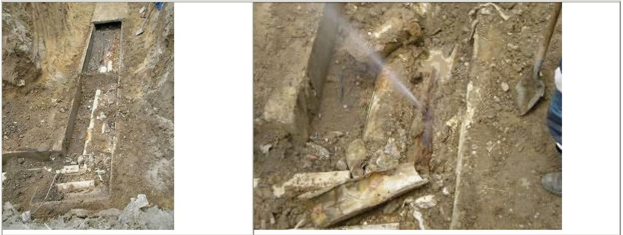
Рис 7. Отсутствие свободного выхода струи. Течь прибором не обнаружена.
